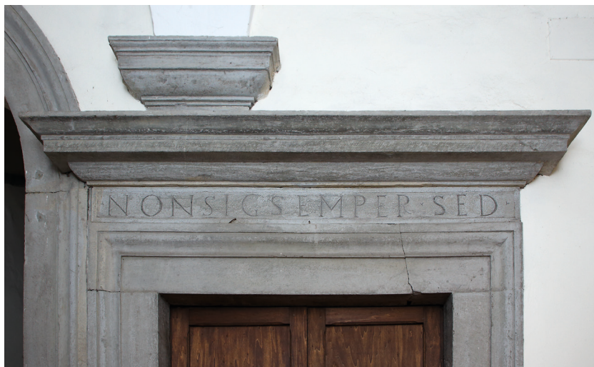
Fig. 14 - Palazzo Graziani, Via XX Settembre 127. Architrave con la scritta NON SIC SEMPER SED. Il portalino in questione è l'ultimo sulla destra del corridoio che dà accesso alle rampe che portano al primo piano.
