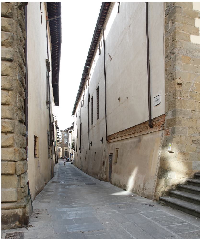
Fig. 49 - Imboccatura di Via Fiorenzuola. Sul lato destro del Palazzo di Residenza è ben visibile l'imposta di partenza dell'arcone che si appoggiava, dall'altro lato, sul fianco di Palazzo Aggiunti. Oggi il manufatto è abbattuto.
