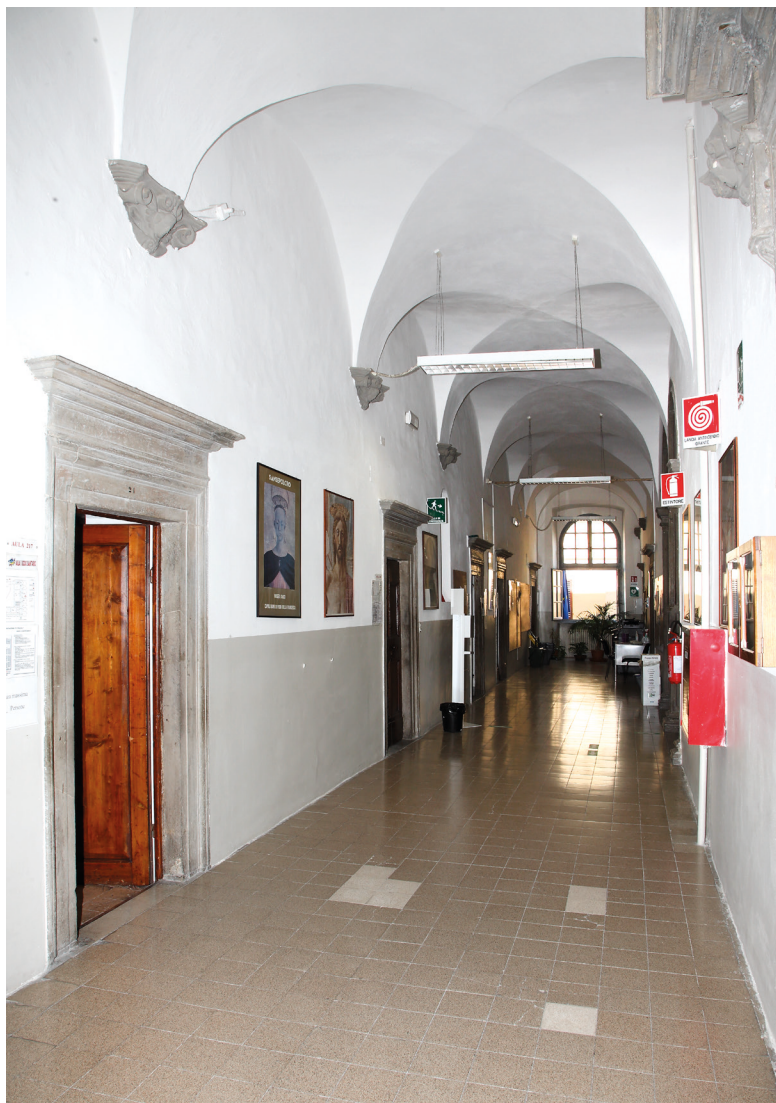
Fig. 69 - Collegio dei Gesuiti (oggi Istituto Tecnico Economico e Turistico). Corridoio del primo piano. Su questo corridoio, a esse, in direzione di Via XX Settembre e Via Piero della Francesca, si aprono le aule di allora e di oggi. Diversi degli architravi presentano scritte educative.
