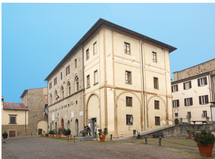
Fig. 48 - Palazzo Pretorio: sede attuale dell'Associazione delle merlettaie di Sansepolcro. Nel '500, come evidenziano bene gli arconi, oggi tamponati, questo spazio era una loggia aperta.
