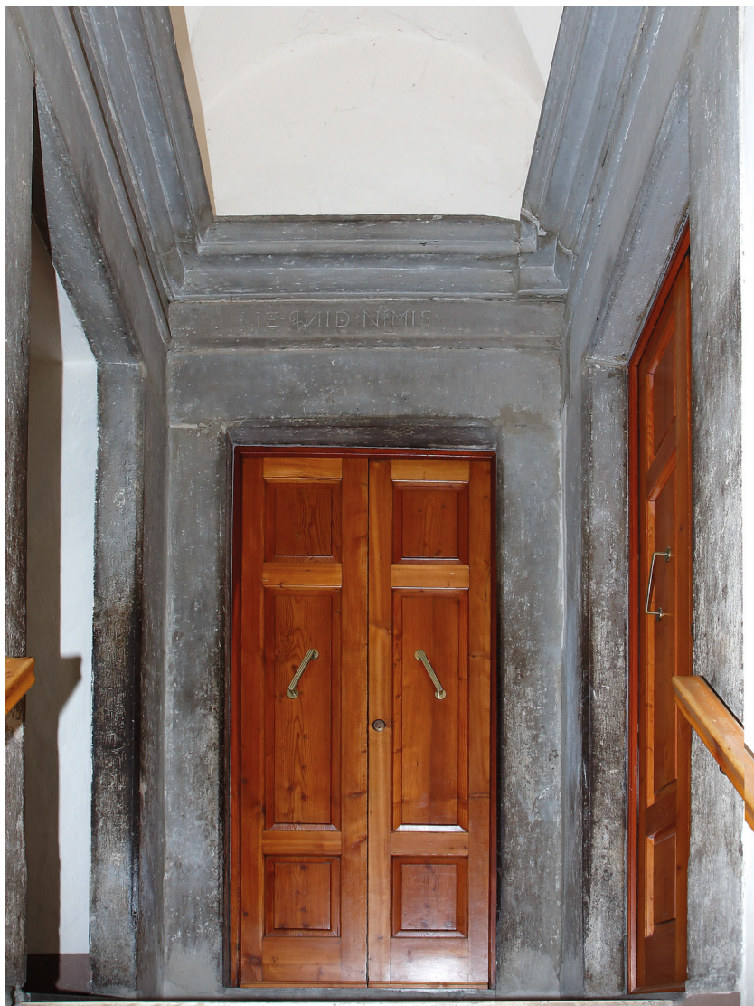
Fig. 55 - Palazzetto di Via dei Servi 27. Lo spazio di disbrigo al primo piano con i portali cinquecenteschi.
