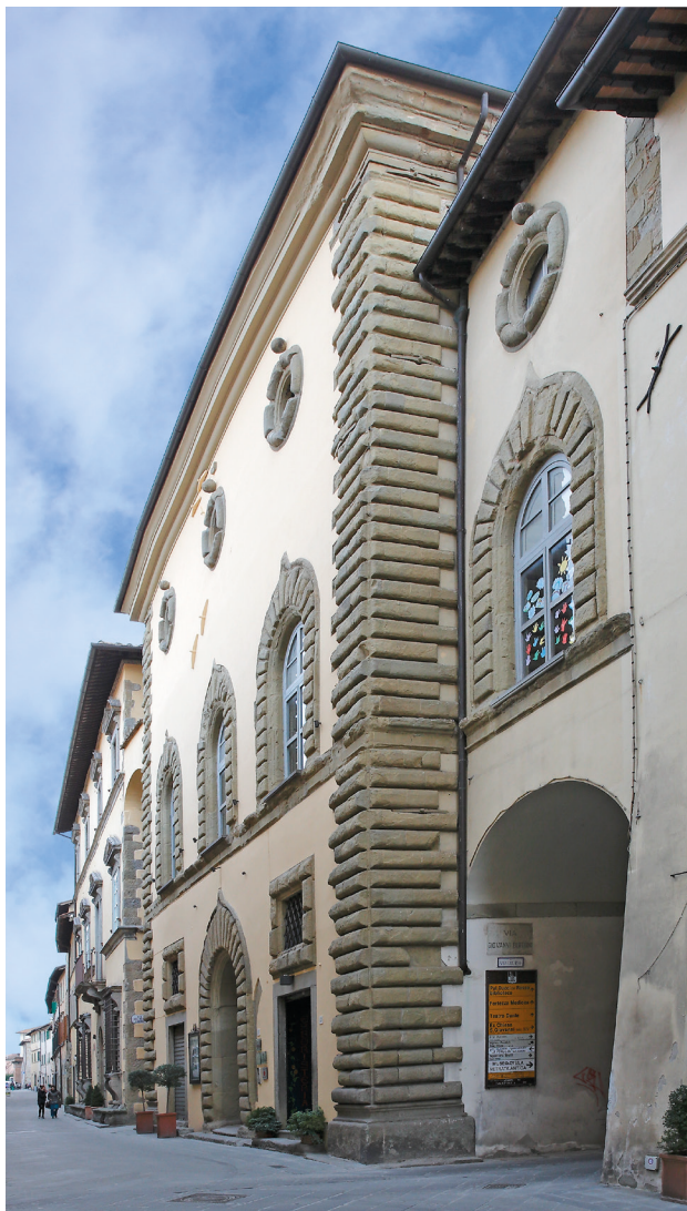
Fig. 12 - Palazzo Graziani. La facciata del palazzo di Via XX Settembre 127.
