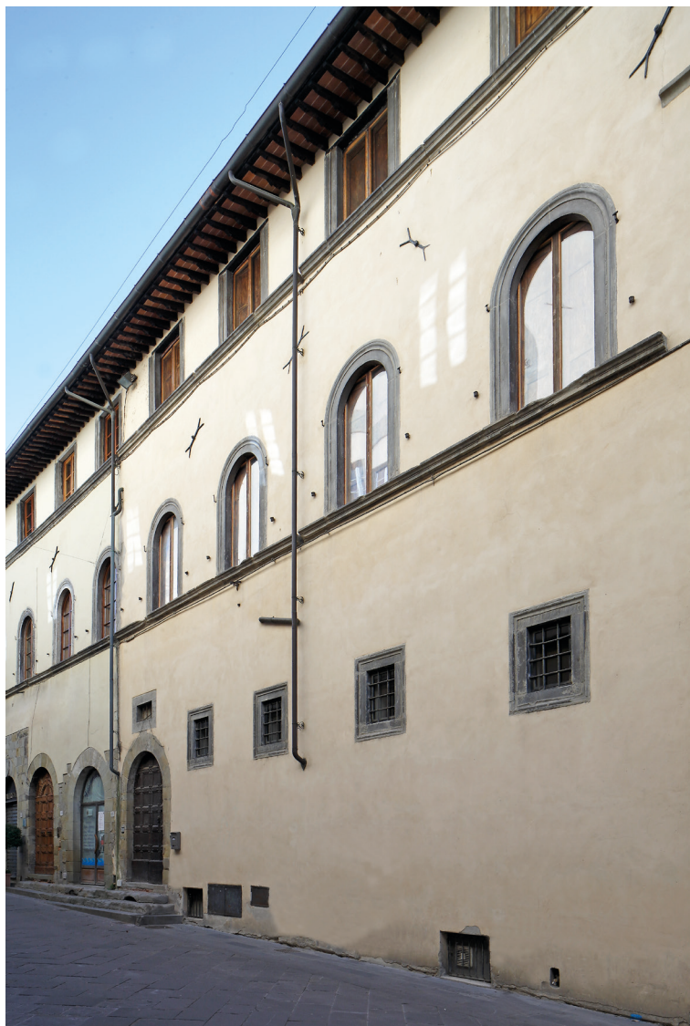
Fig. 15 - Via XX Settembre, 121. Palazzo Graziani poi Fabbri Irmaria. La scritta COGNOSCE TE IPSUM è in un architrave del vano che prende luce dalle prime due finestrelle quadrate sulla destra.
