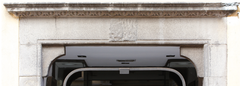
Fig. 38 - Via XX Settembre 133: ambiente che oggi è negozio di abbigliamento. Portalino in pietra con architrave fortemente aggettante decorato in basso da un grazioso filaretto di ovoli. Questo motivo compare a Sansepolcro con i cantieri del Palazzo della Residenza (Sovrintendente Piero della Francesca) e dell'Abbazia poi Cattedrale (committenti Simone e Galeotto Graziani).
