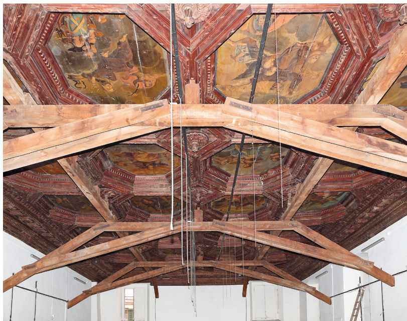
Fig. 40 - Ex Chiesa degli Osservanti: conserva un pregevole soffitto ligneo, iniziato nel 1649 dai Fratelli Binoni e completato nel 1705 dal pittore Angelo Angelucci. Gli elementi a capriate sono posti attualmente a sostegno del soffitto.
