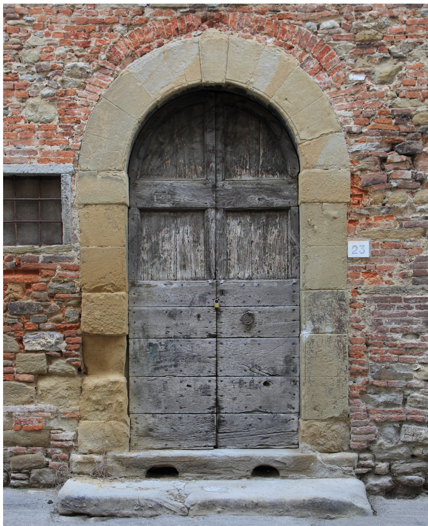
Fig. 85 - Un portale rinascimentale, povero, probabilmente di fine 400 o inizio 500. Si vede che è costruito a bozze ben tagliate e levigate. Nel Rinascimento maturo montanti e architravi sono modulari, cioè monoblocchi.
