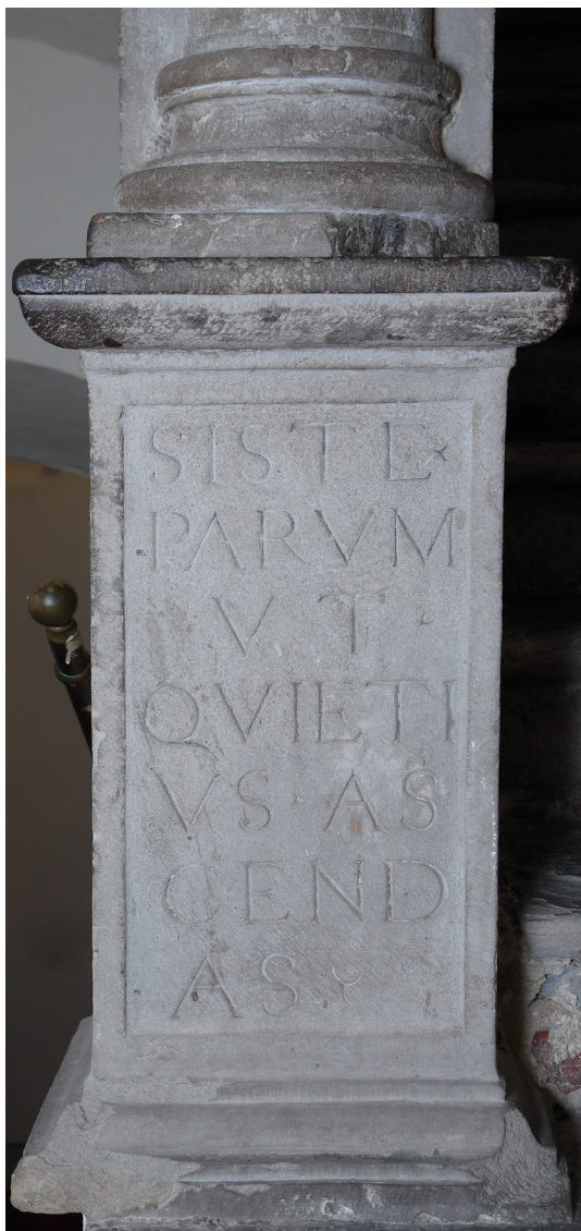
Fig. 33 - Palazzo Ducci Del Rosso, Via XX Settembre 131. La scritta sullo zoccolo della colonna che segnala la parete di inversione della scalinata che porta al primo piano: SISTE PARUM....
