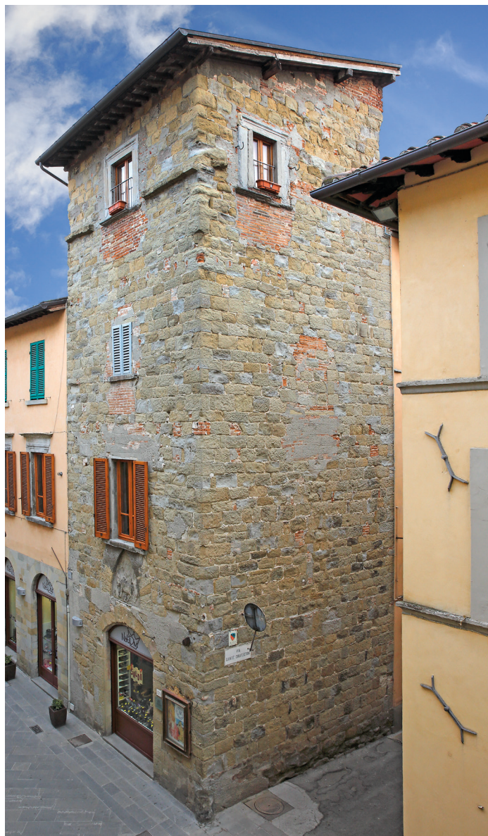
Fig. 77 - Via XX Settembre. La torre di Palazzo Taurini.
