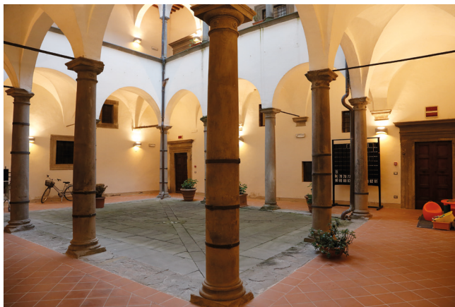
Fig. 32 - Palazzo Ducci Del Rosso, Via XX Settembre 131. Il grazioso chiostro tardo rinascimentale.
